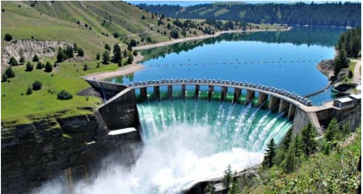
Hidroelektrik Enerji Santrali
